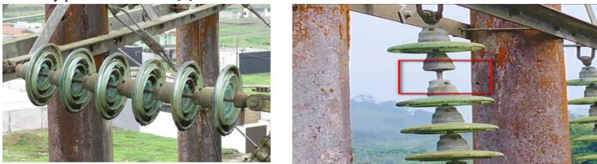
Figura 3. Aisladores con polución y roto
